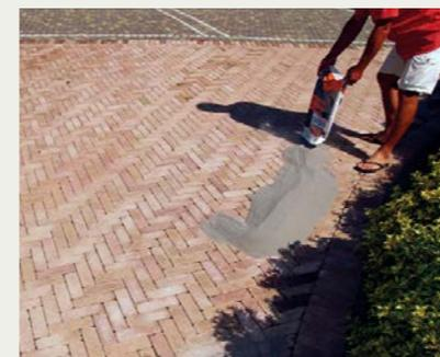
Corretto utilizzo della sabbia polimerica. Cospargere la pavimentazione con la sabbia polimerica.
